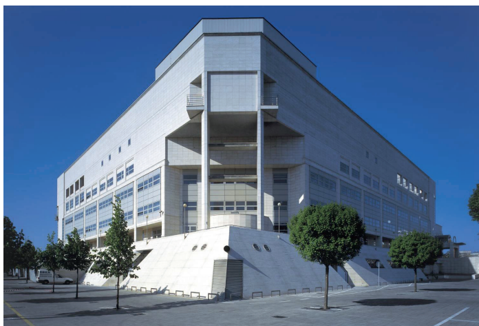
Obr. 6: Budova SND po dokončení. Zdroj: Archív A BKPS
