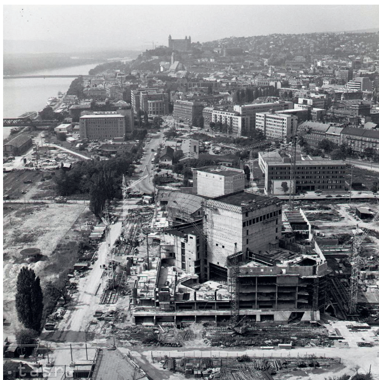
Obr. 4: Budova SND počas výstavby. Zdroj: Archív A BKPS
